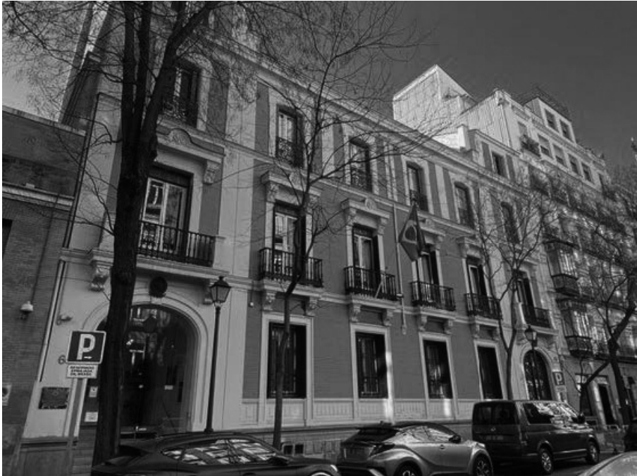
“Building of the Brazilian Embassy in Madrid.” https://www.gov.br/mre/pt-br/embaixada-madri/madri-arquivos/historia-do-edificio-da-embaixada .
